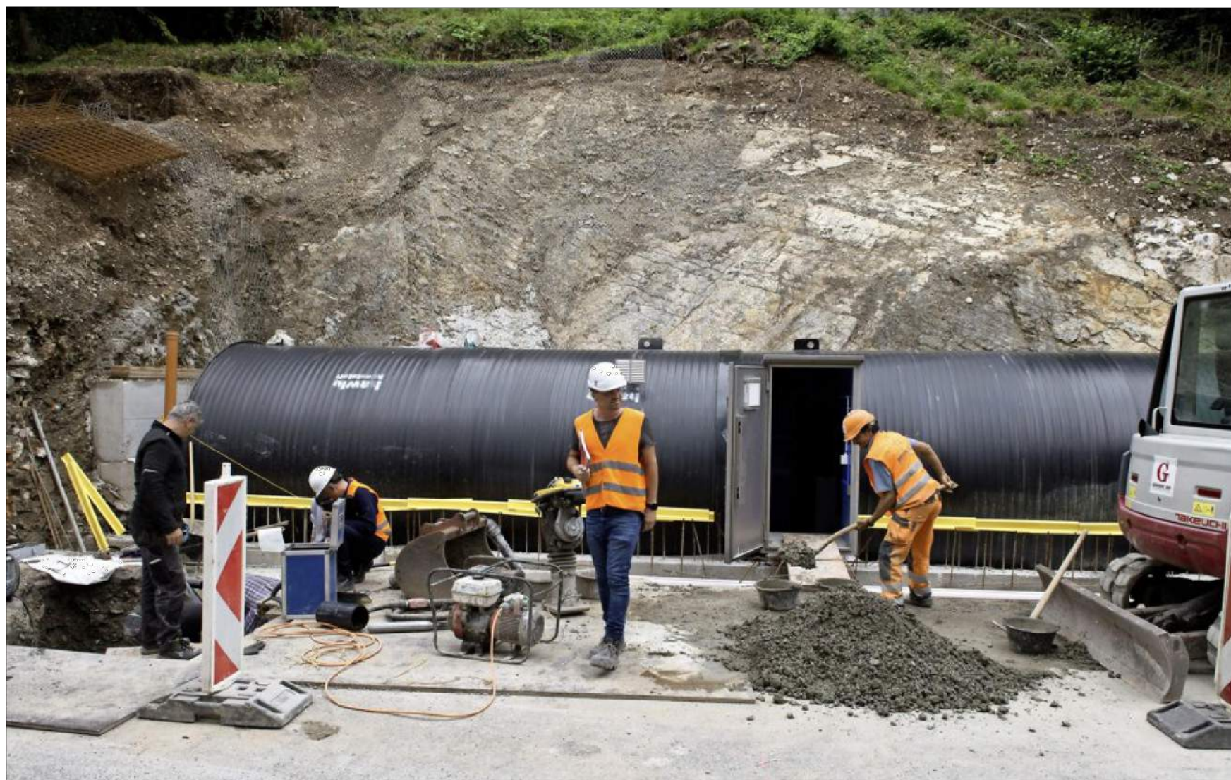
A la rue du Temple, une chambre de rassemblement des eaux a été installée. Le réservoir de 200 m 3 sera posé l'an prochain. DOMINICFAVRE
